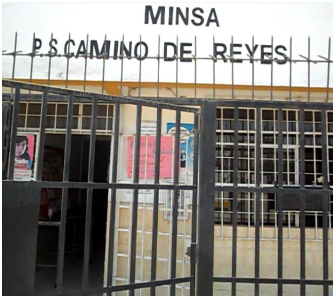
Figura 18: Puerta De Ingreso Del Puesto De Salud Camino De Reyes
