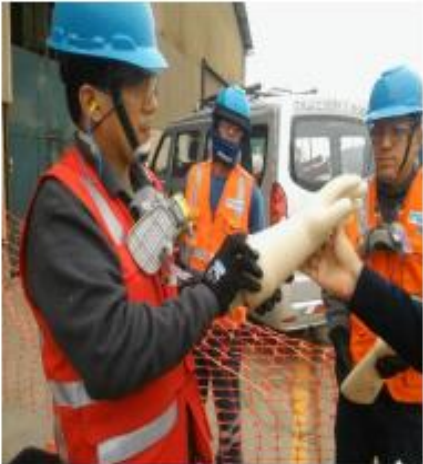
Prueba del buen estado de guantes Dieléctricos
