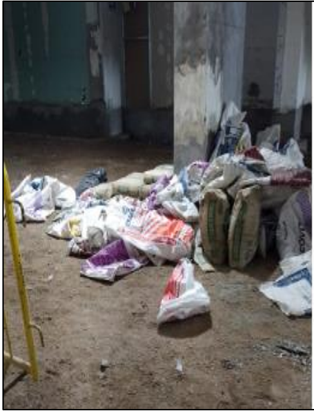
Figura 25 - Falta de orden y limpieza
